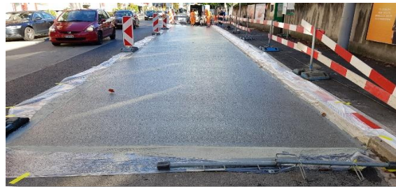
Frisch eingebauter VB11 (hier das Produkt CONFALT)
