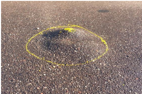
Dampfblase unter Gussasphalt ("Warze")
