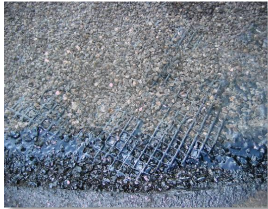
Stressabsorbing Mastix Inlay (SAMI) spannungsabsorbierende Membrane
