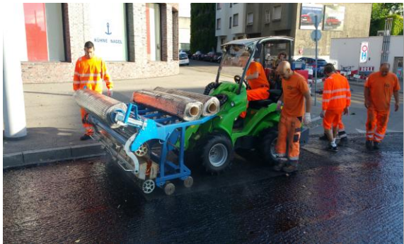
Carbophalt-Netz wird in einem Kreisel verlegt
