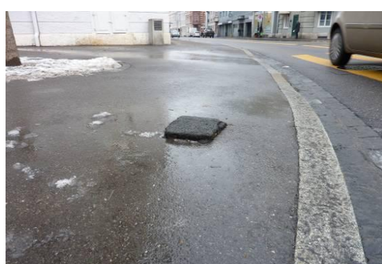
Frosthebung (keine Frostsicherheit)
