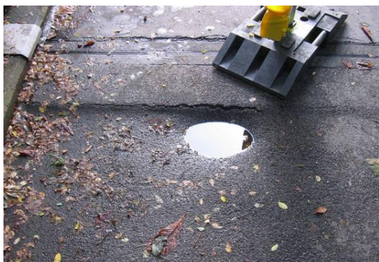
Senkung (ungenügende Verdichtung)
