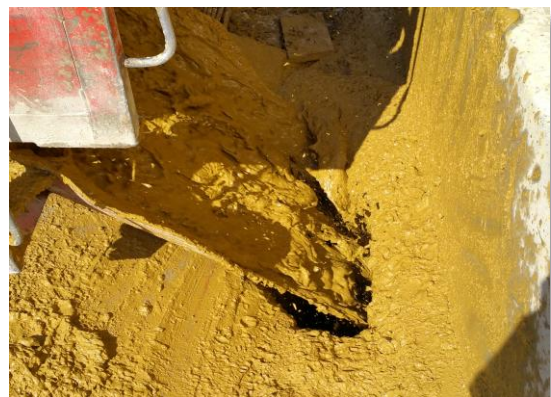
Verfüllen von unerwünschten Hohlräumen (Rühlwand)
