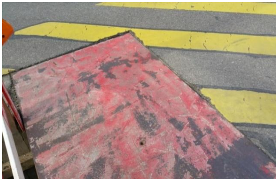
Versenkte Stahlplatte in Fahrbahn
