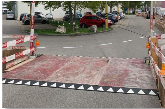
Aufgelegte gesicherte Stahlplatte mit System FLEYG
