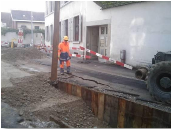
Werkleitungsgräben: Spriessung zu spät gezogen
