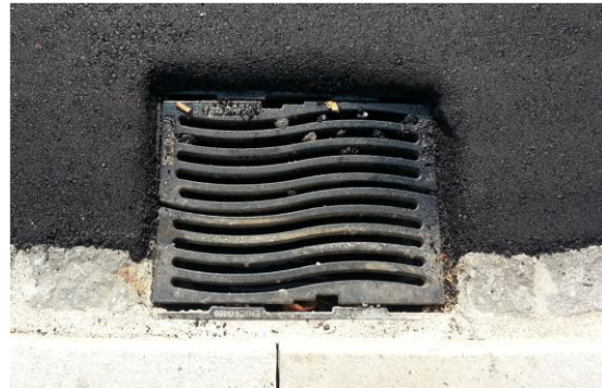
Zu tief eingebauter Einlaufrost
