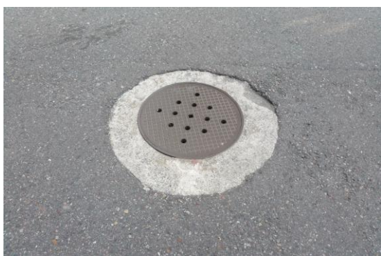
Beton statt Belag (Blick auf Binderschicht)
