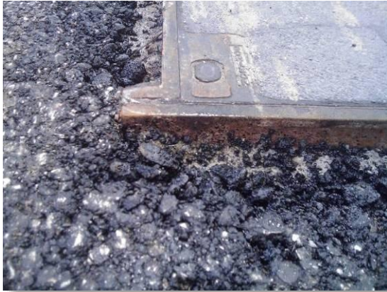
Tragschicht zu hoch gebaut
