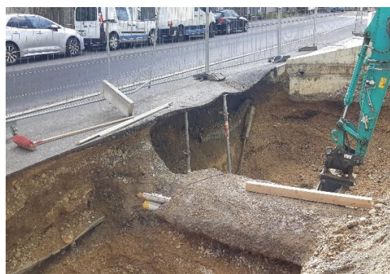
Fehlende Spriessung (2.5 m Tiefe) Baugrube
