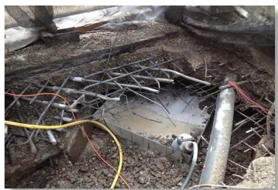
Durchtrennen statischer Brückenbewehrung
