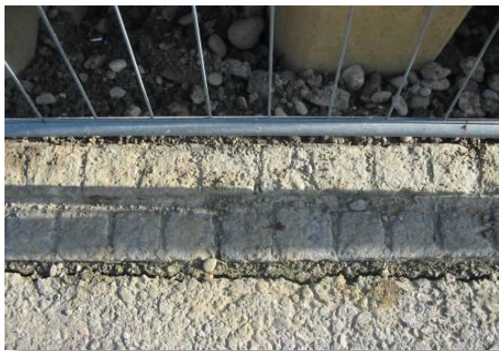
Abgehängter Randabschluss (Baugrube)
