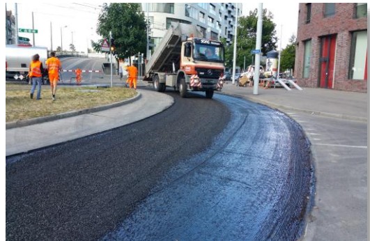
SAMI mit vorumhülltem Split wird eingebracht
