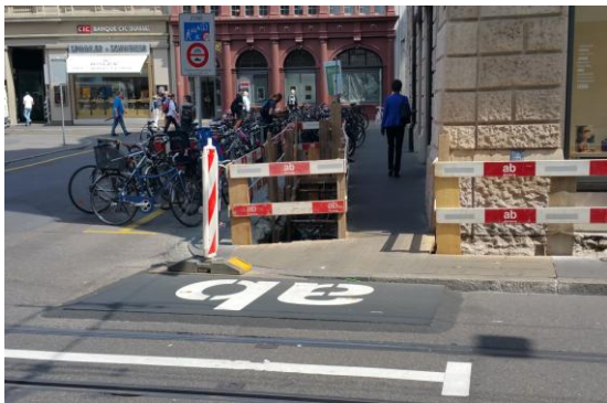
Versenkte Holzdielen mit angerampter Stahlplatte
