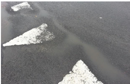
Übermässiger Abrieb in 3-jährigem Testbelag
