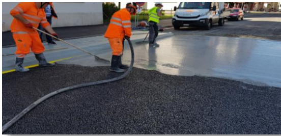
Verfüllen des bituminösen Belags mit der Schlämme
